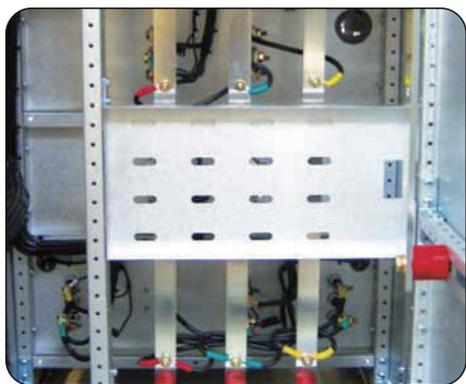
c) 固定分隔式 MCC 柜垂直母线
