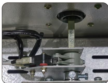
图七 连锁机构
